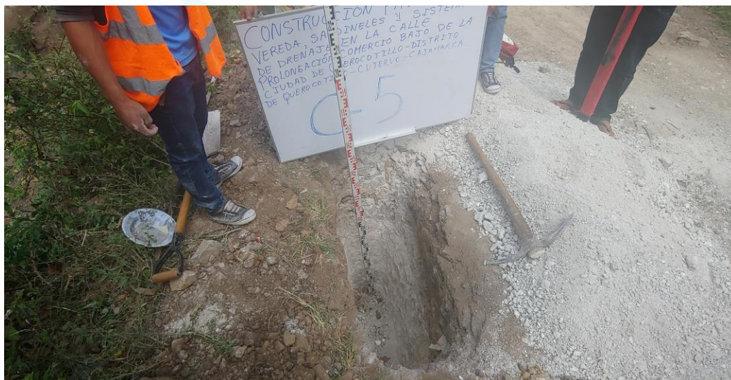
FOTO N° 17: VISTA A CIELO ABIERTO DE LA CALICATA.
