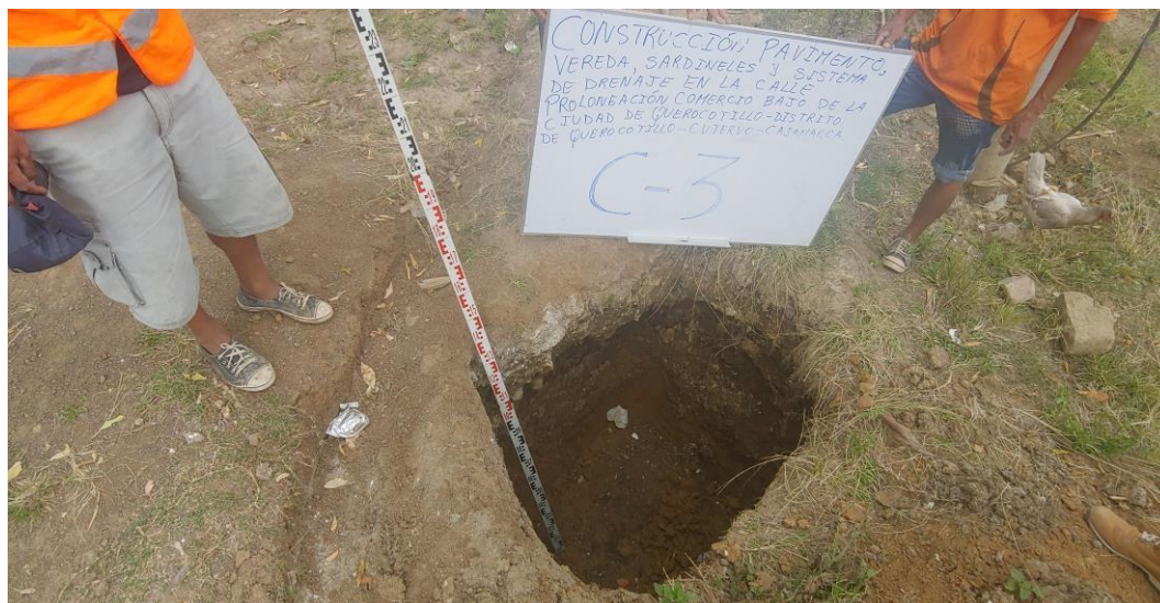
FOTO N° 11: VISTA A CIELO ABIERTO DE LA CALICATA.
