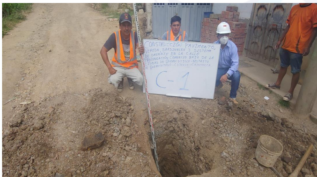
FOTO N° 04: VISTA A CIELO ABIERTO DE LA CALICATA NUMERO 01.
